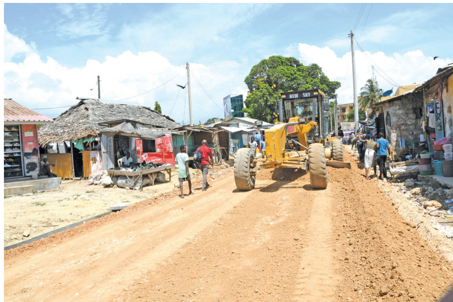
Moja ya barabara zinazojengwa katika mtaa wa mabanda wa Baya Magonzi mjini Kilifi. Serikali ya kitaifa, kupitia KISIP, inatumia Sh1.2 bilioni kuboresha mitaa saba ya mabanda katika miji ya Kilifi na Malindi, Kaunti ya Kilifi.
